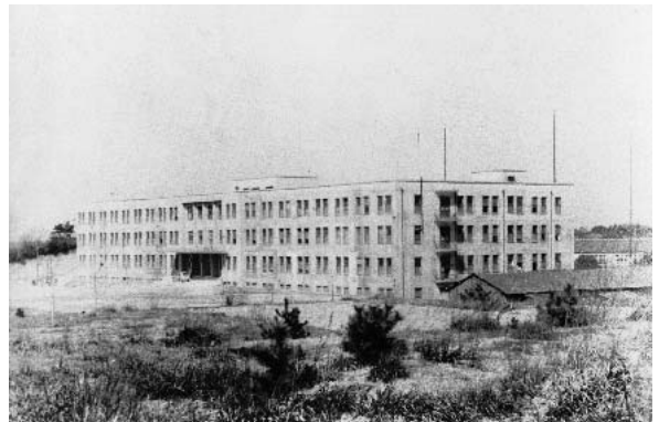
写真1：完成間近の工学部旧1号館
