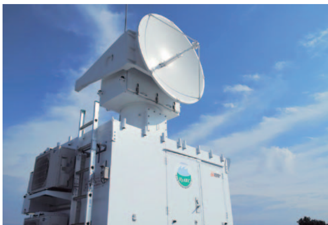
環境共用館屋上に設置された雲レーダ
