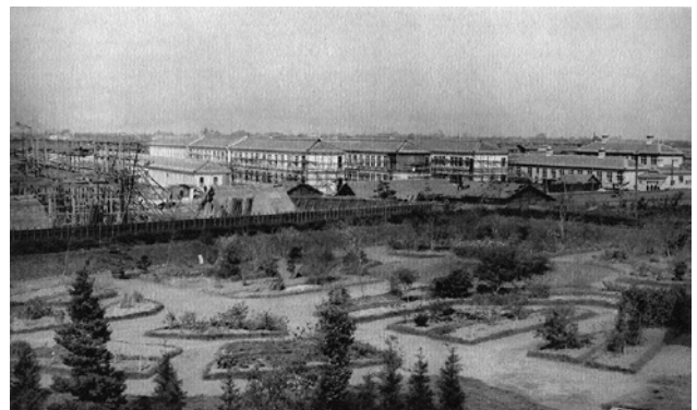
建設途中の愛知県立医学専門学校の鶴舞校舎（大正初期）
